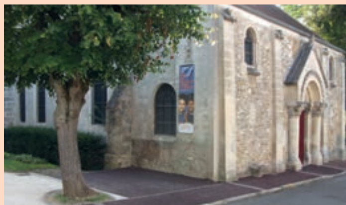
Parking de l'Église et son seuil d'entrée
