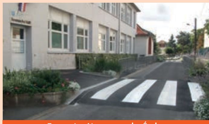
Traversée piétonne rue des Écoles, entrée groupe scolaire Paul Valéry
