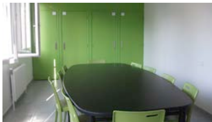
Réfection de la salle Charaintru, salle annexe parc de la mairie
