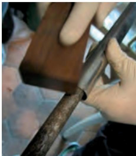
Photo 5 : remise sur forme en acier de tuyaux cabossés
